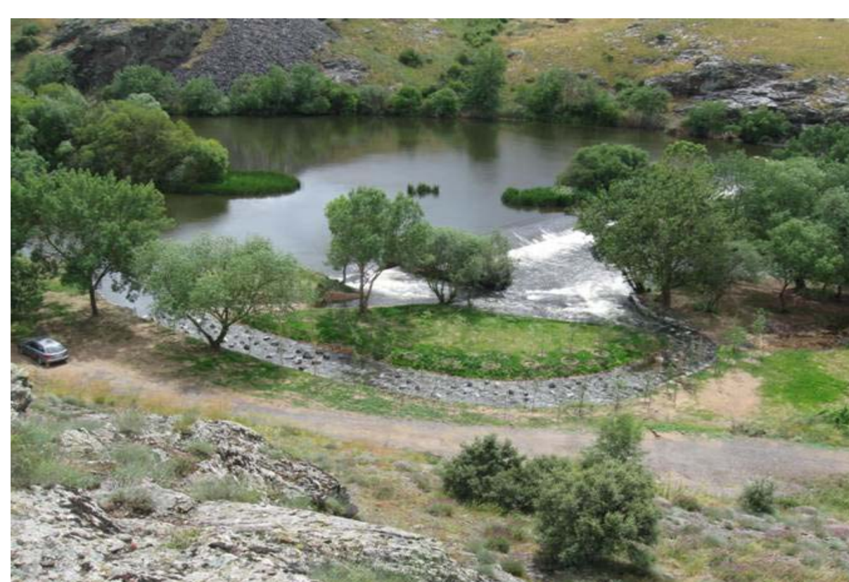
Construcción de ocho escalas de peces en el río Segura.
