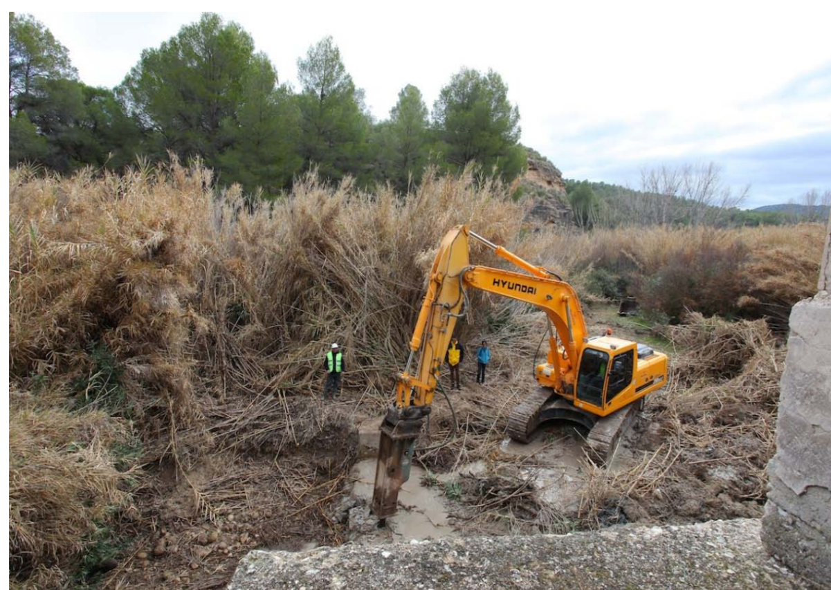
Demolición de un azud en desuso en el río Moratalla localizado dentro de la Red Natura 2000.
